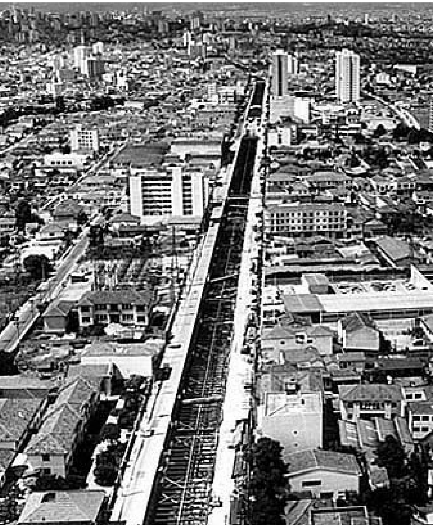
Construção do metrô de São Paulo
